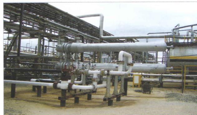
Рис. 4. Установка 3S-сепарации на УКПГ Губкинского месторождения ОАО «Роснефть»
