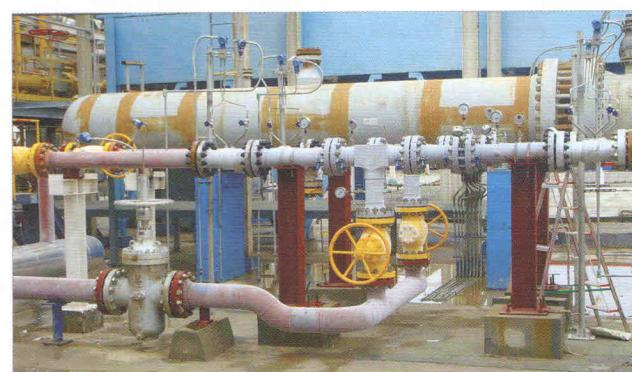
Рис. 5. Блок 3S-сепарации на УПГ месторождения ЯНА компании Petrochina
