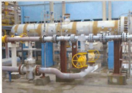
**Рис. 3.** Блок 3S-сепарации на УПГ месторождения YANA компании PetroChina
