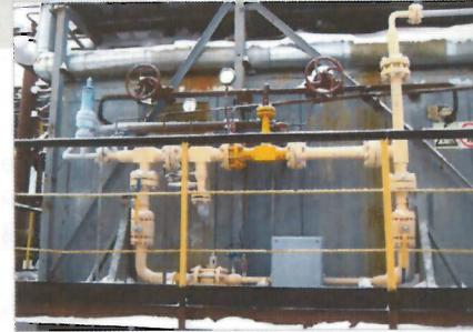
**Рис. 4.** Установка 3S-сепарации на Заполярном месторождении ОАО "Газпром"
