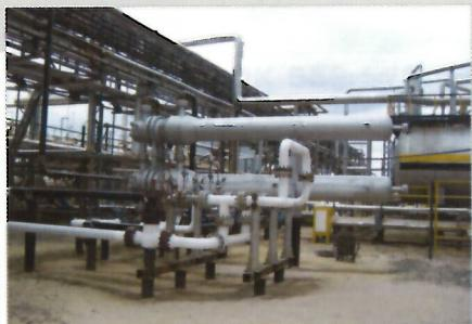
**Рис. 2.** Установка 3S-сепарации на УКПГ Губкинского месторождения ОАО "Роснефть"
